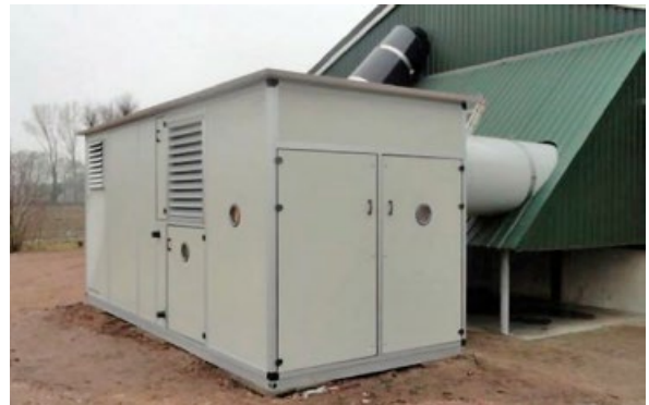
Nagyméretű központi hőviszanyerő hőcserélő az istálló mellé telepítve
