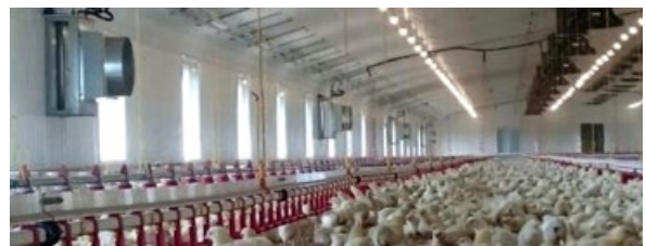
Oldalfali vizes termoventilátorok teremfűtéshez és mennyezeti sugárzó fűtés, gerinc mentén a használt levegő elszívása
